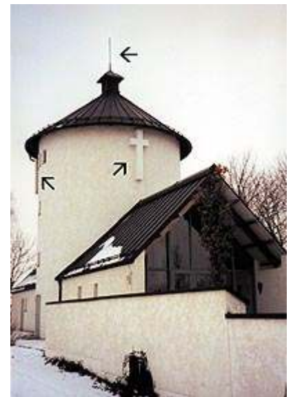
Oft sind Antennen versteckt angebracht wie hier im Kreuz bei einem Friedhof. Foto: Ulrich-Raithel
