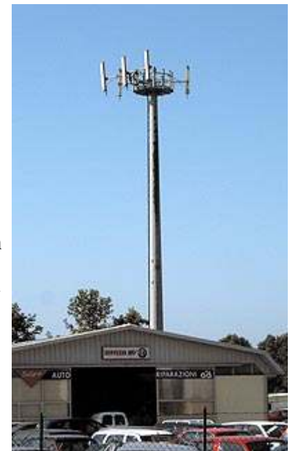
Wegen der niedrigeren Grenzwerte gibt es in Italien kaum Dachstandorte. Foto: Ulrich-Raithe
