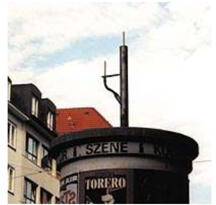
Kleine Antenne zur Versorgung des Nahbereichs. Foto: Ulrich-Raithel
